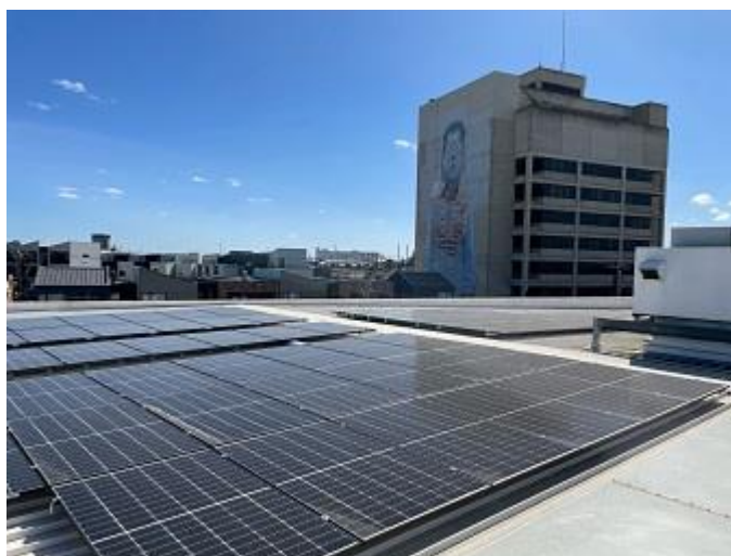
296 St Vincent Street, Port Adelaide, SA
