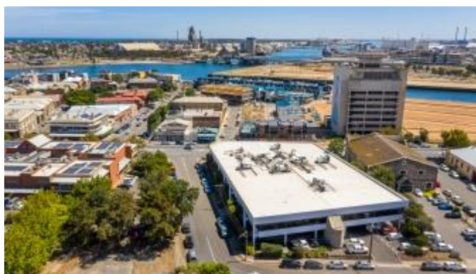
296 St Vincent Street, Port Adelaide, SA
